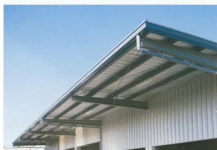
鉄骨現わし大庇
